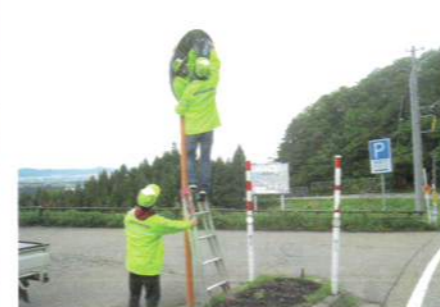
「カーブミラー」の点検・清掃活動 (5月14日 春の運動期間中、大鋸屋地区支部:同集落内)
